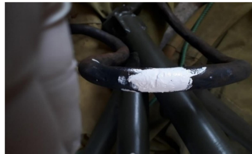
Vá lại cáp bằng silicon siêu kỵ nước
