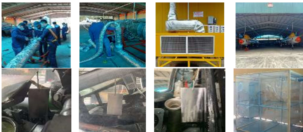
Hình 3. Một số hình ảnh thi công lắp đặt hệ thống thiết bị và các mẫu thử nghiệm
