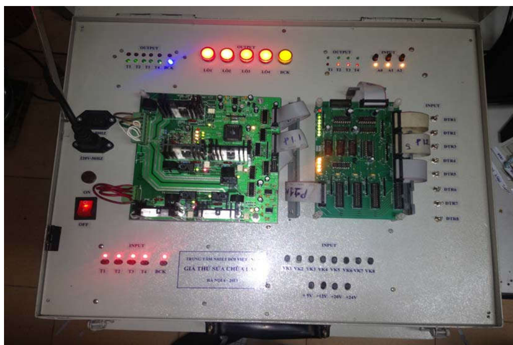
Hình 8. Hình ảnh Khối 2 - Khối sửa chữa khối đơn đang làm việc
